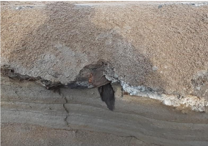
Kuva 11. Koekuopassa 31 oli mm. puuta ja betonikerros.
