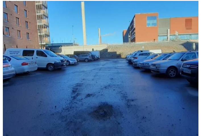
Kuva 2. Edessä kairapisteen 24 kohta asfaltissa.
